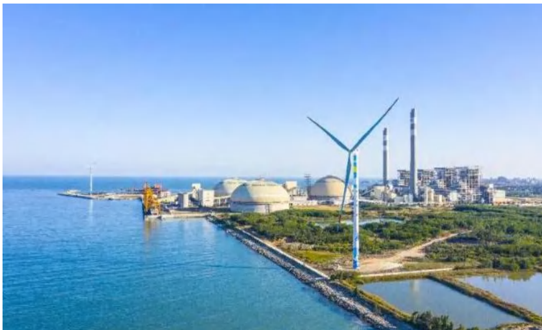
图 5.3.1-3 广东汕尾电厂一期工程
