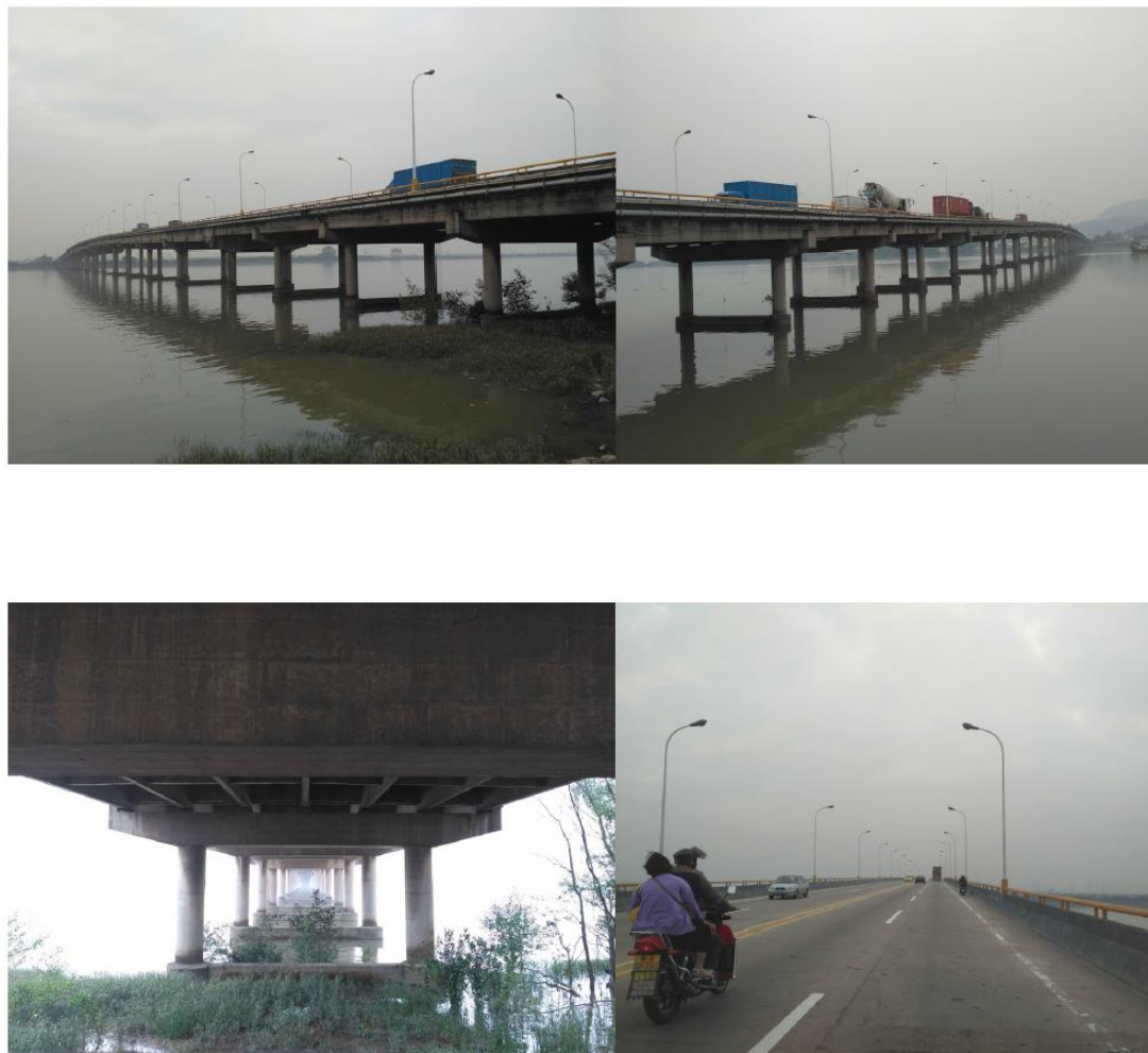
图 3-6 亭角大桥现状图
